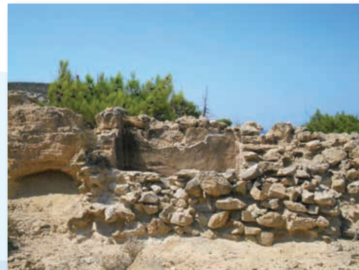
Φρεάτιο του υδραγωγείου με μονολιθικό πυθμένα που καλύπτεται εσωτερικά με υδραυλικό κονίαμα. Drain of the aqueduct with monolithic bottom covered with hydraulic mortar.
